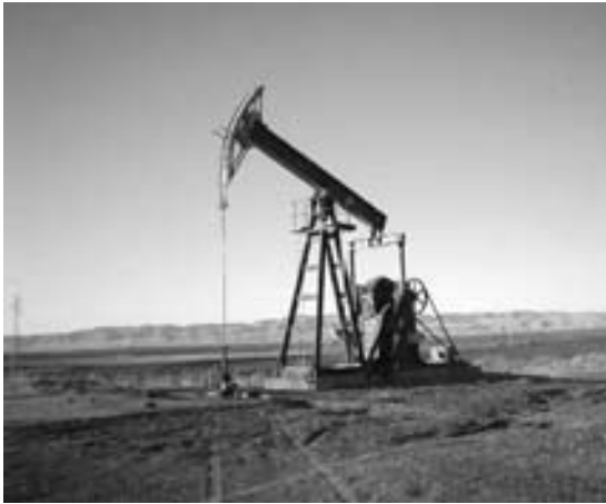
تضررت جراء تسربات النفط.
